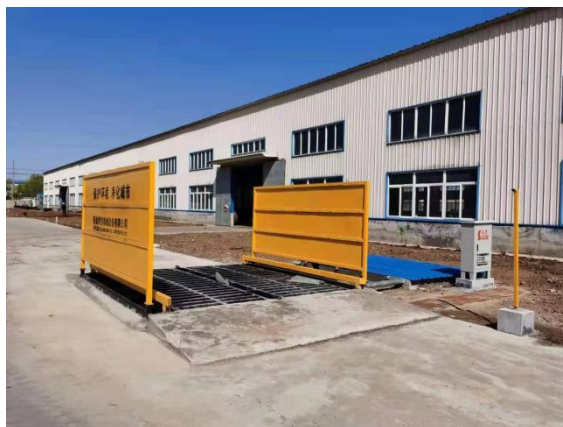
图 4-1 洗车平台、沉淀池
