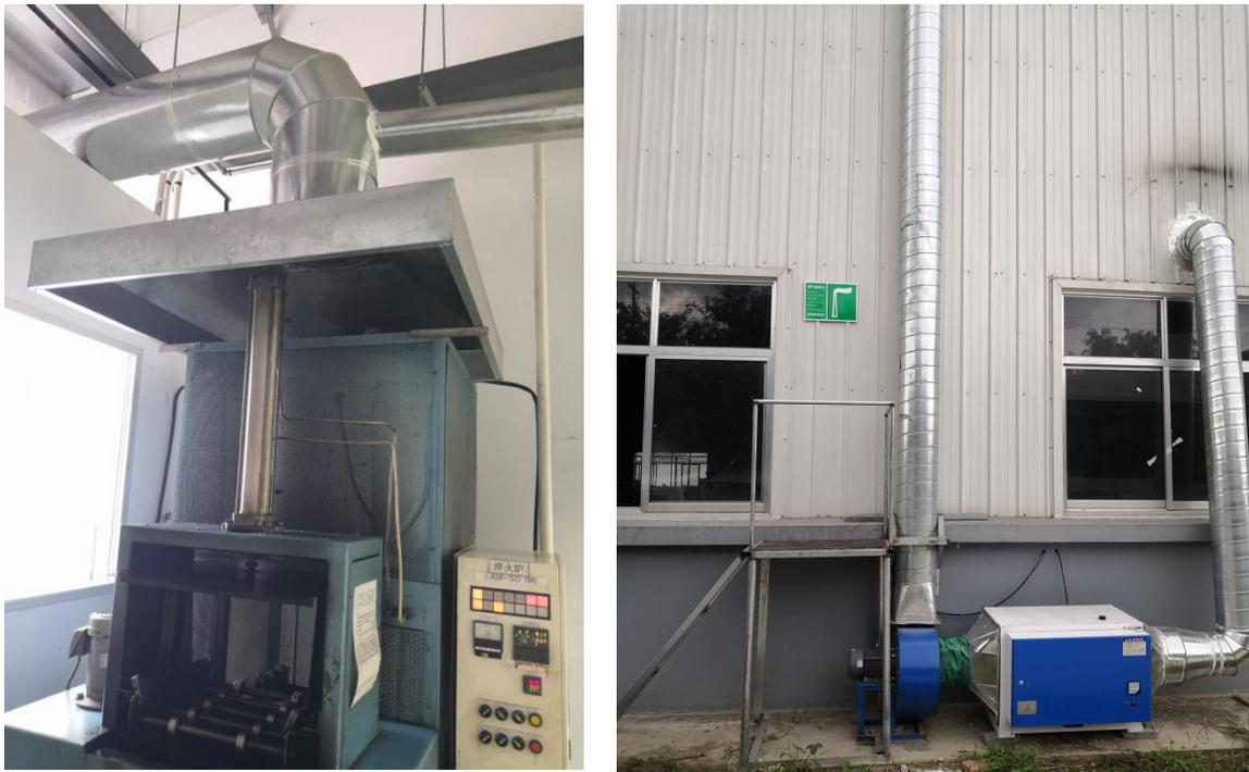
图4-1 废气集气罩、处理设施
